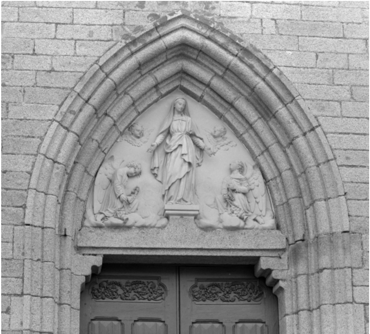
Elévation ouest, porte : détail du tympan
