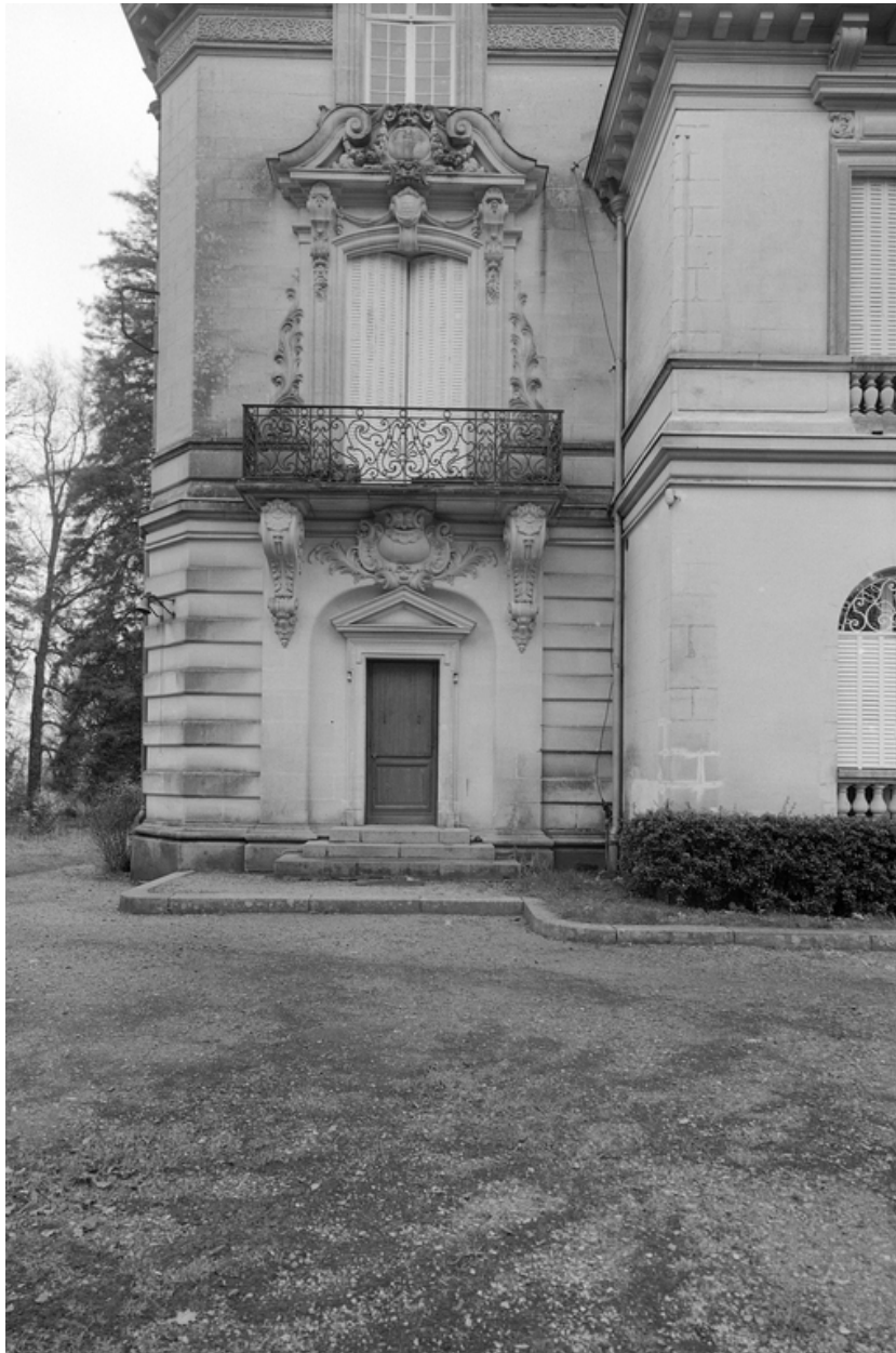
Vue de détail de la façade sud.
