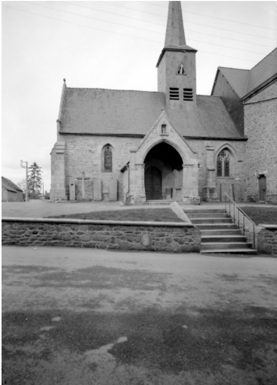
Elévation Sud, partie Ouest: vue générale
