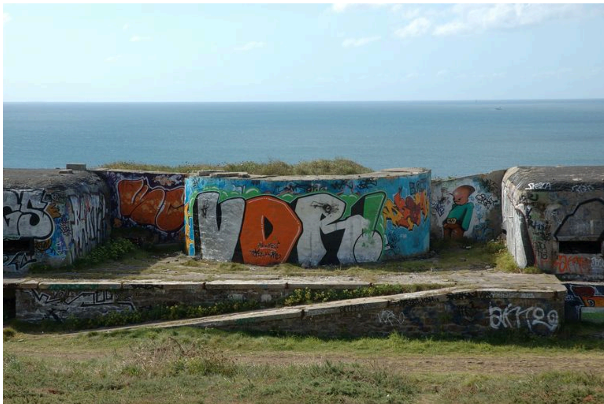
Vue d'un emplacement de pièce (état en 2007)
