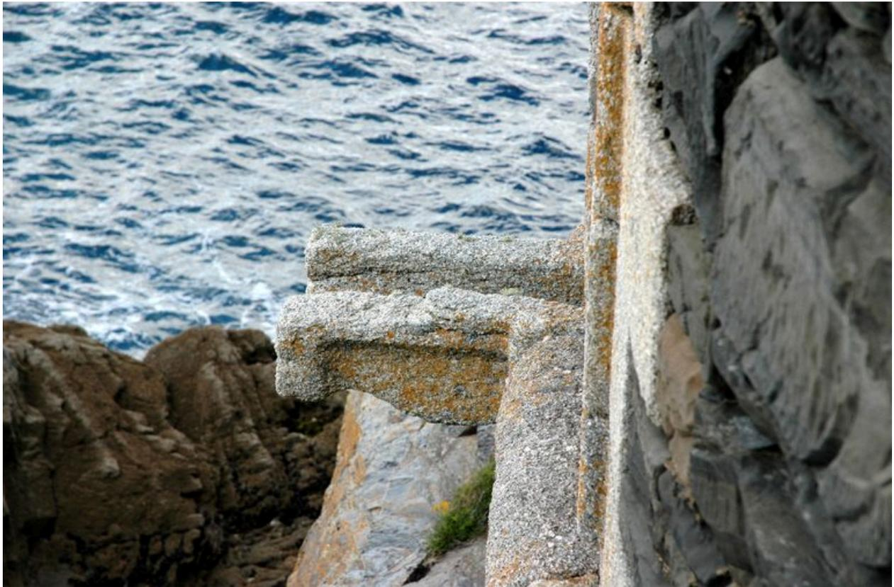
Vue de la batterie de Cornouaille : détail du parapet. Gargouille ouvragée et cordon en granite ; remplissage en moellons de schiste
