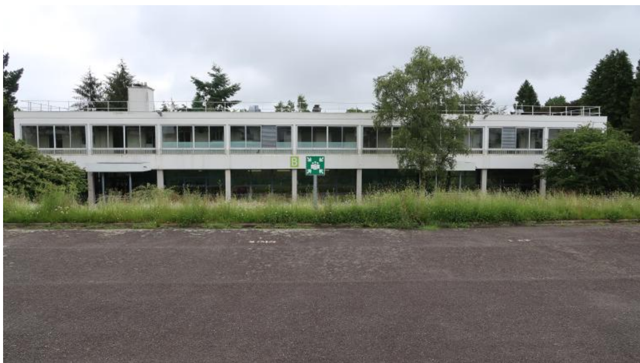
Façade ouest du bâtiment B (restauration, CDI...).
