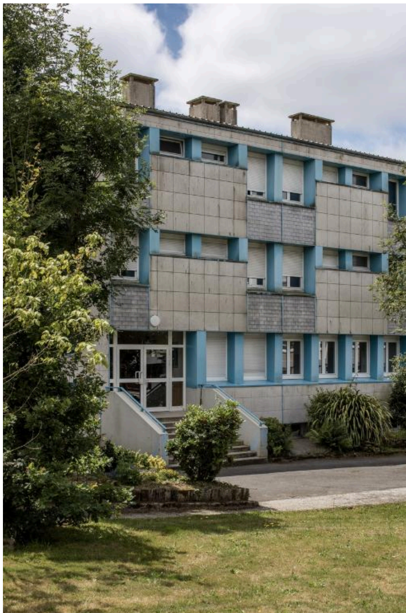
Administration, façade nord : vue partielle. Péron et Weisbein, architectes, 1967-1968.
