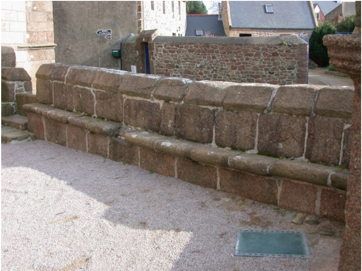
Mur de clôture, banc intérieur
