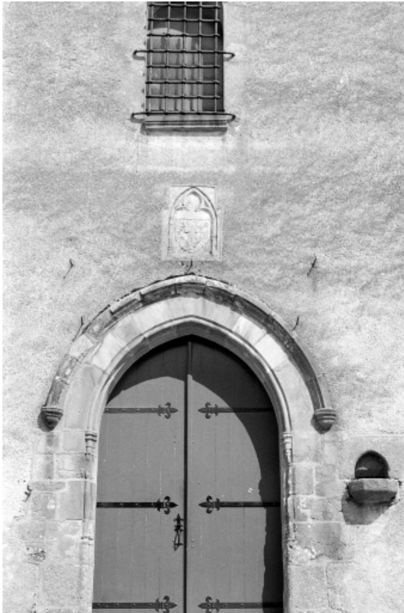
Porte surmontée d'un blason
