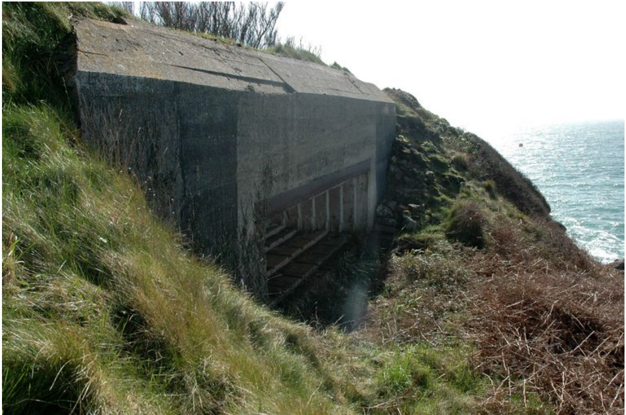
Vue de l'ensemble fortifié de la pointe du Renard : casemate pour canon de 75 mm orienté vers l'entrée du port du Conquet
