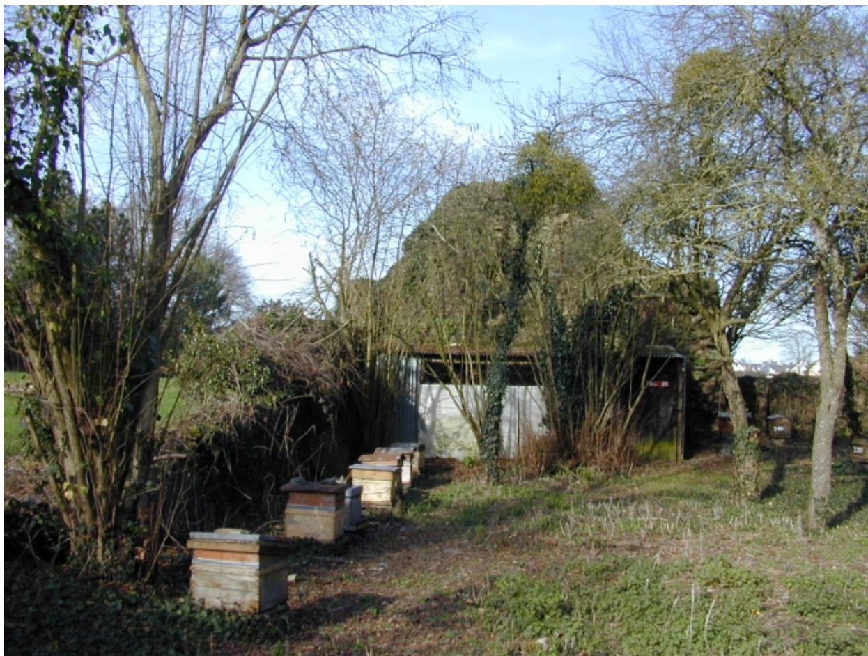
Vestiges des anciennes écuries
