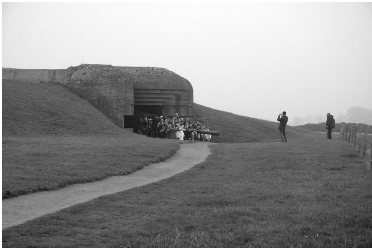
Vue générale de l'une des quatre casemates de la batterie de Longues-sur-Mer (casemate n° 4 depuis l'est)
