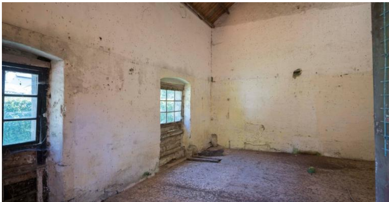
Bâtiment principal. Salle 4, dite salle de peignage des fibres
