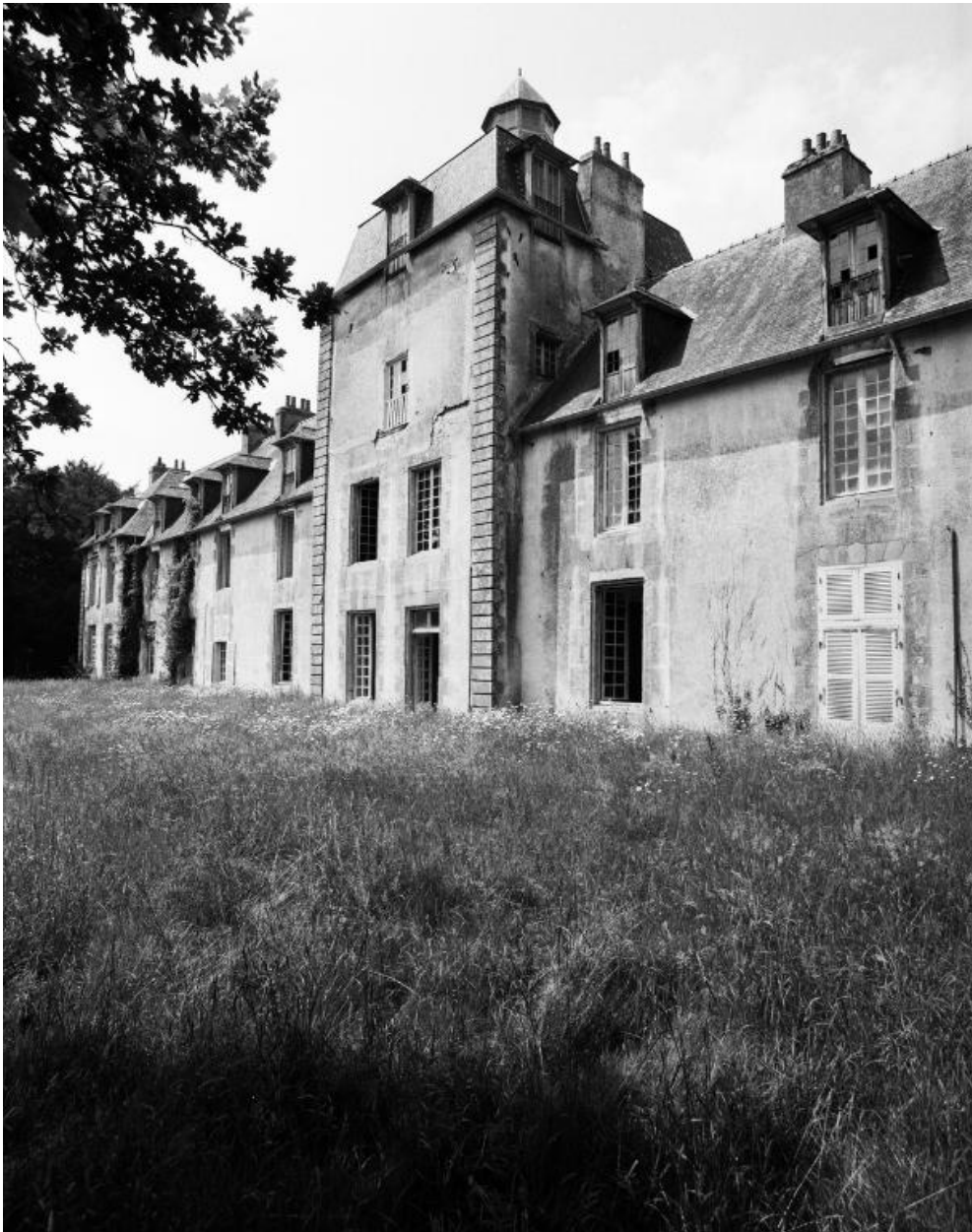
Elévation sud, partie centrale, vue prise de l'est.
