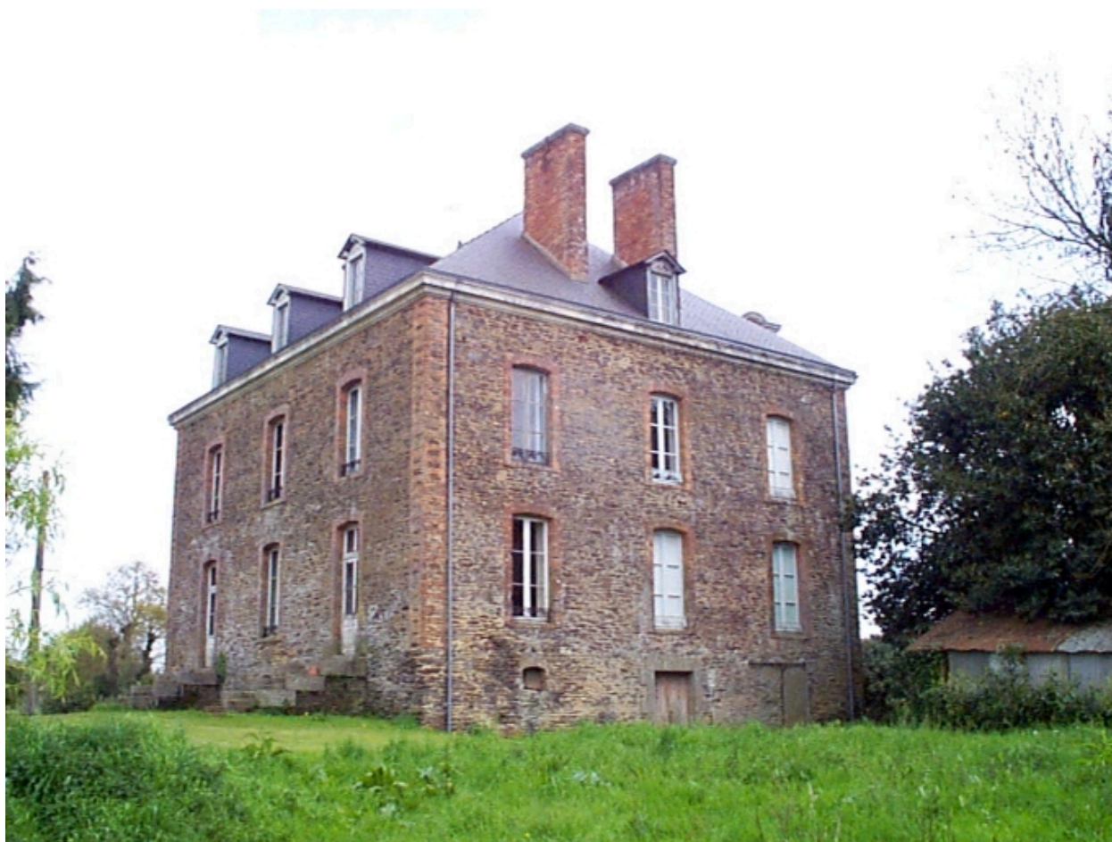
Pignon ouest : vue générale
