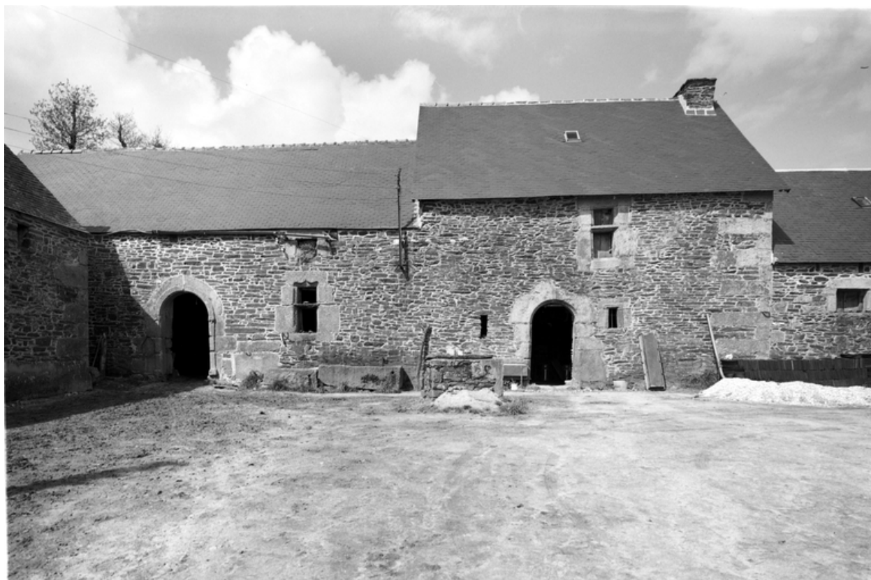
Vue générale façade sud
