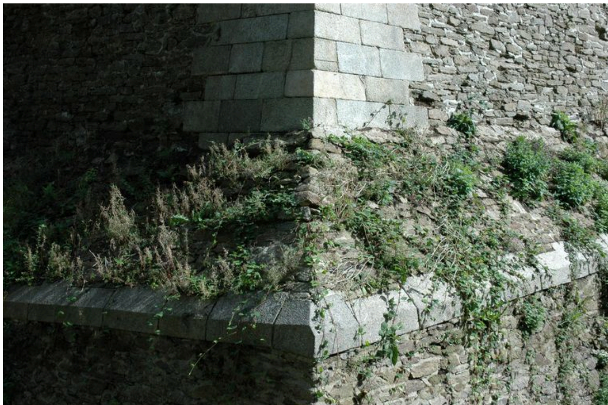
Vue de l'ouvrage à cornes de Quéliverzan
