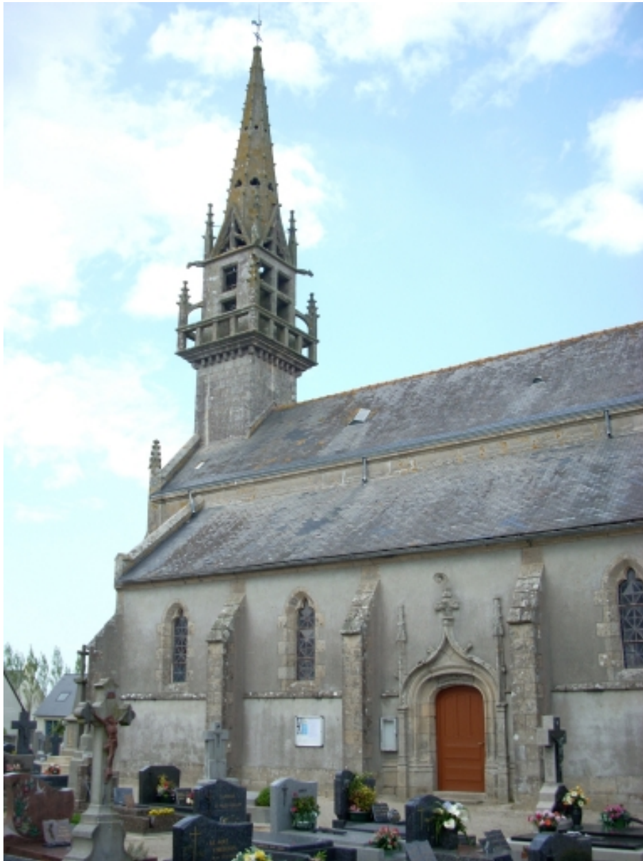
Guiler-sur-Goyen, église paroissiale Saint-Justin : vue générale sud-est
