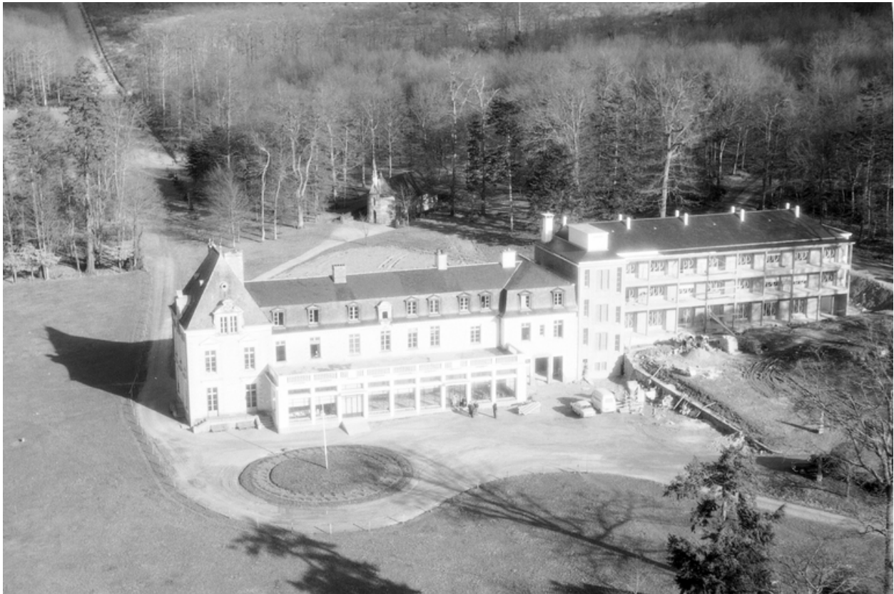
Vue aérienne rapprochée ouest.
