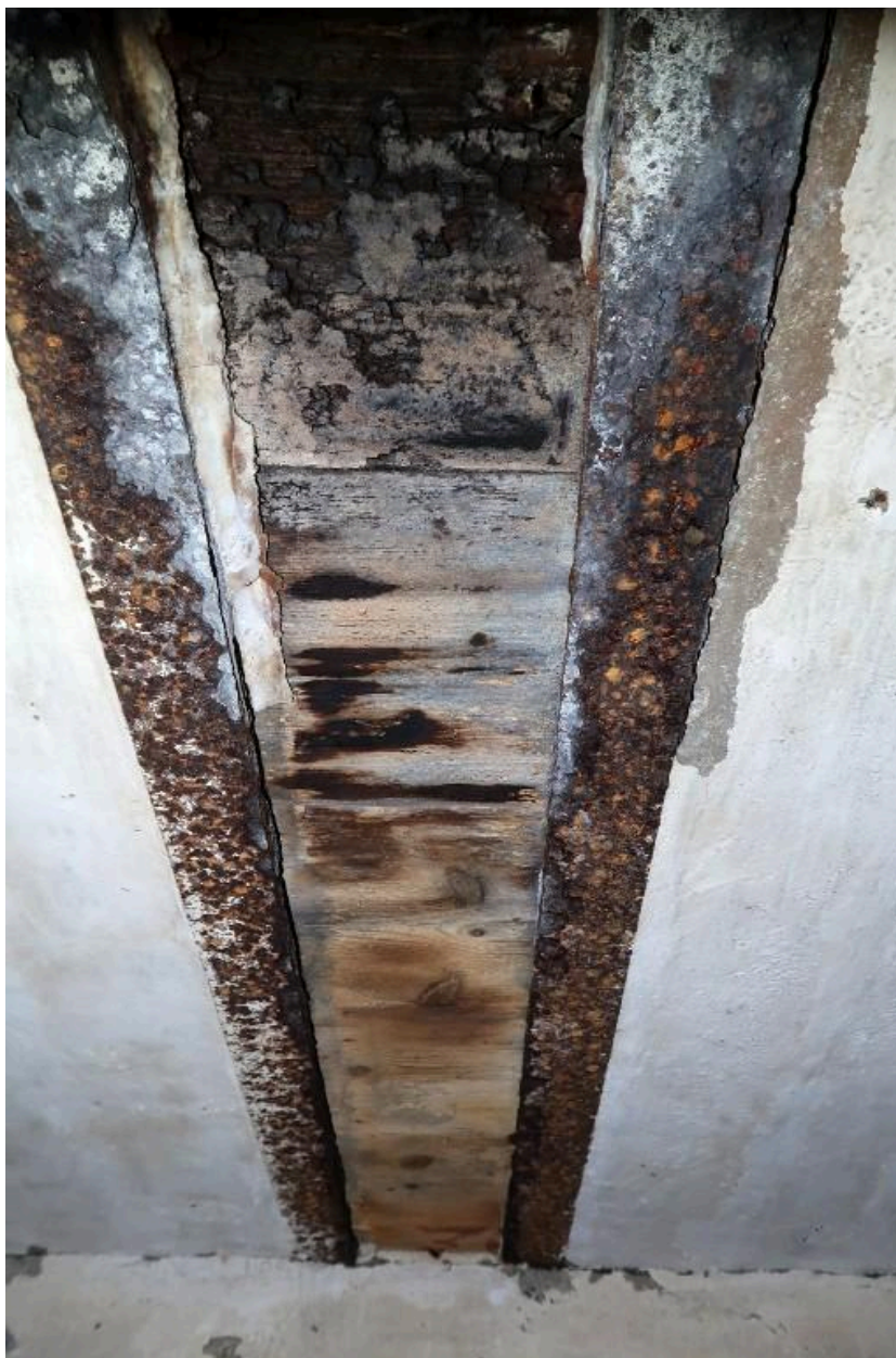
Vue intérieure : détail du plafond de la salle de garde ouest, puits pour un périscopes ?
