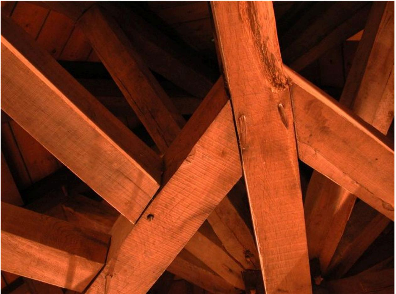
4e niveau : détail de la charpente supportant la toiture à six pans
