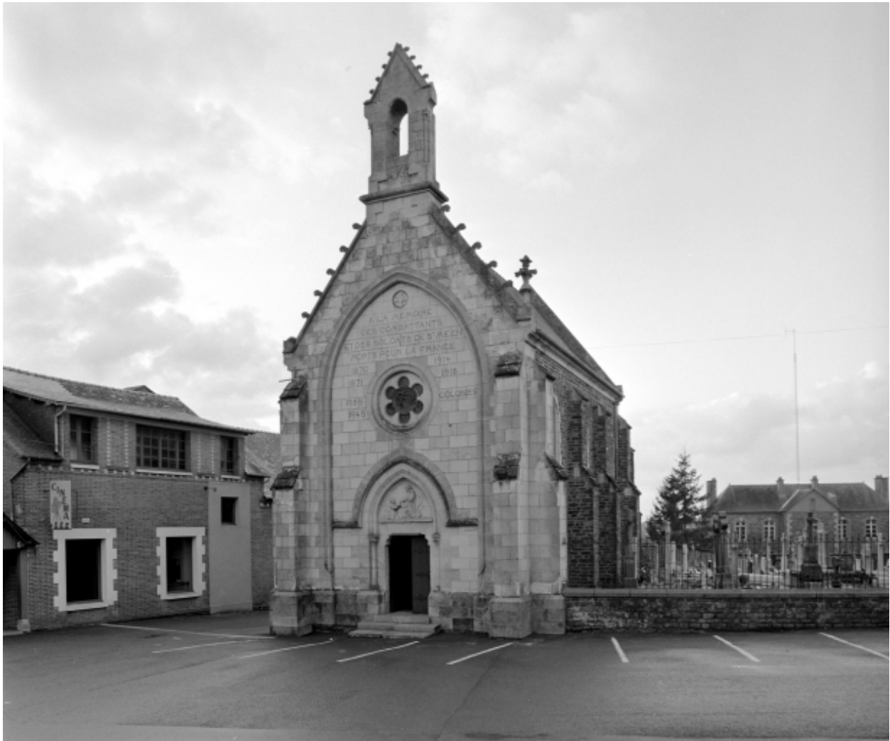
Elévation Nord-Est : vue de situation
