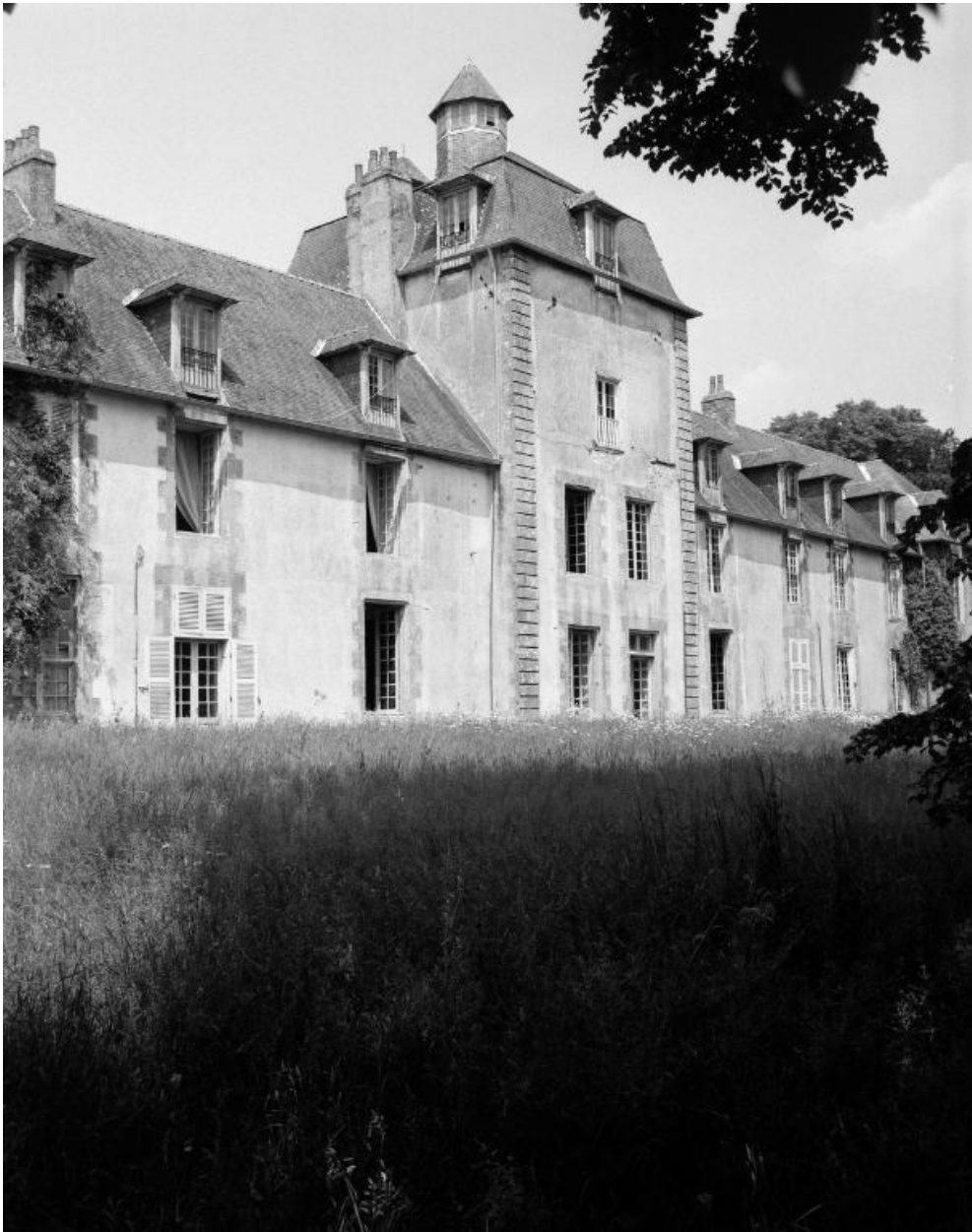
Elévation sud, partie centrale, vue prise de l'ouest.
