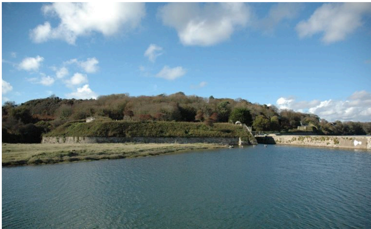
Vue générale des lignes de Quéléren au niveau de l'entrée du bourg de Roscanvel
