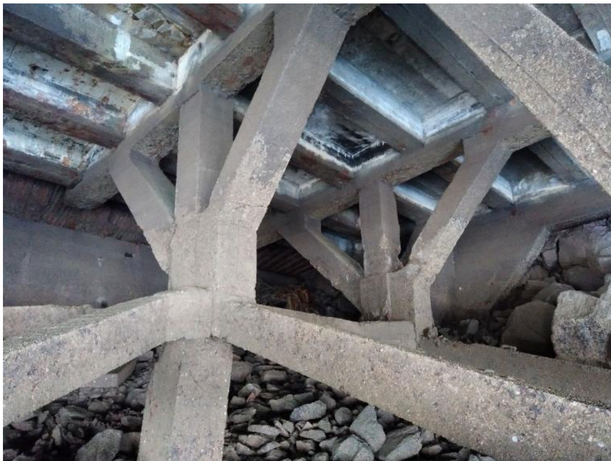
Treillis ou claire-voie en béton armé
