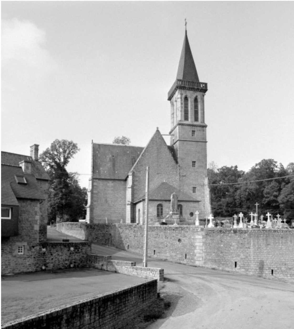
Elévation Est : vue générale
