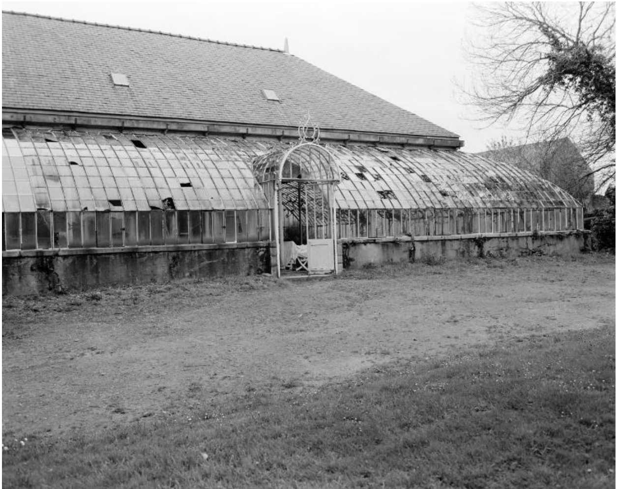
Serre, vue générale sud.
