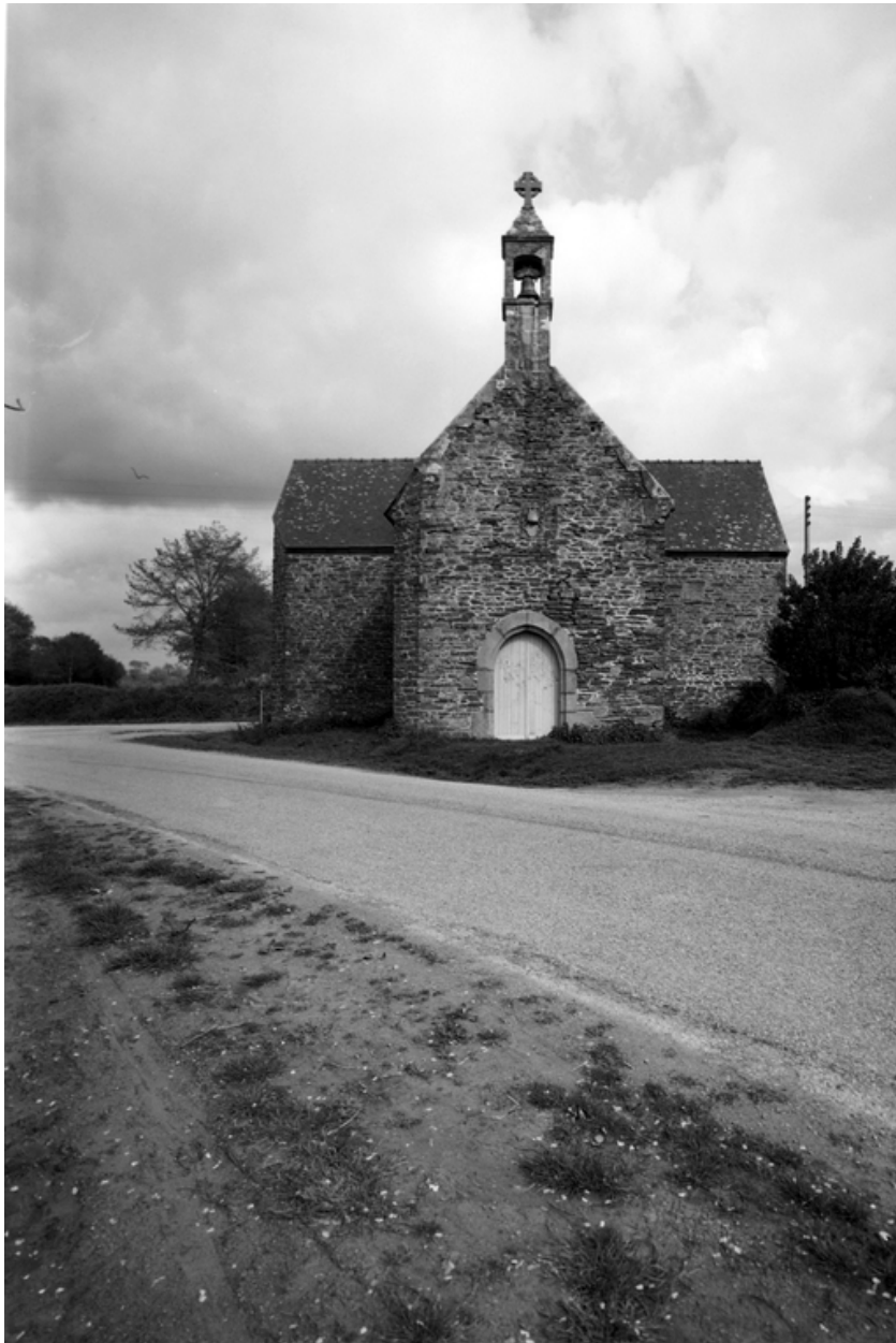
Vue générale, extérieur (ouest)
