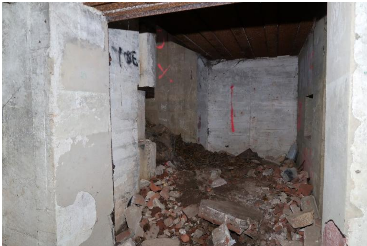
Vue intérieure : sas de l'entrée nord
