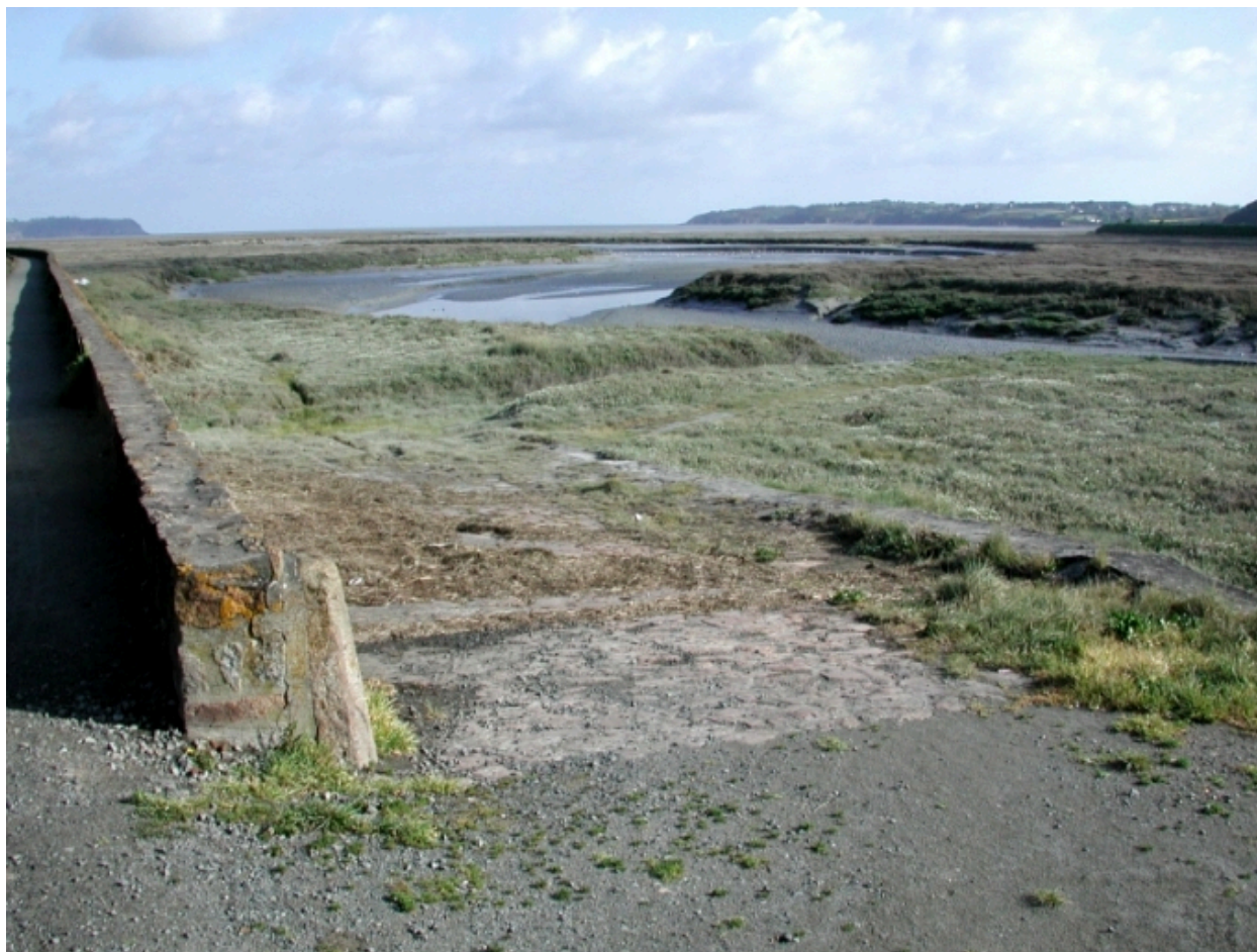
Cale de Ruzé-Bréha
