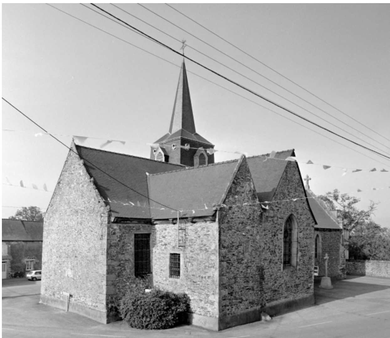
Élévation Sud-Ouest : vue générale
