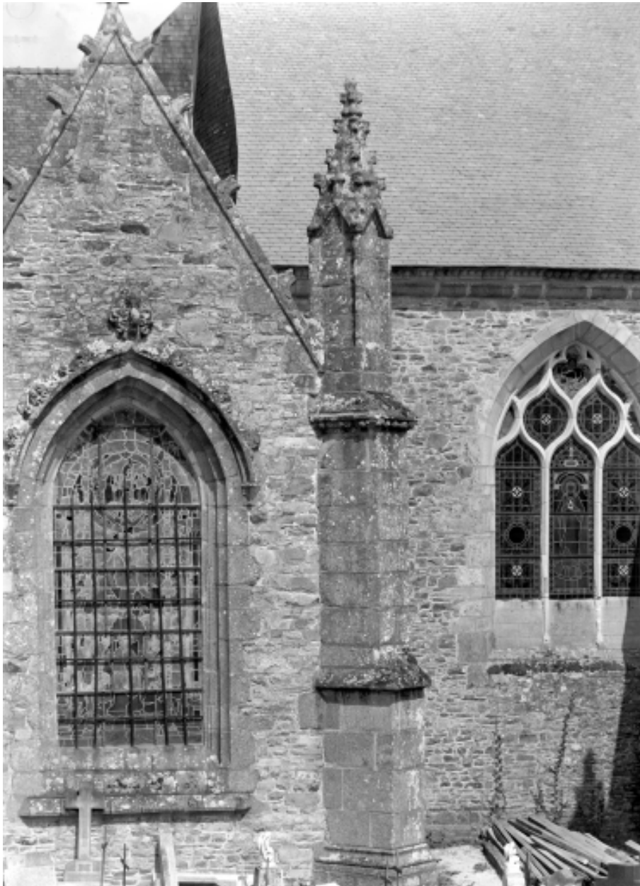
Elévation sud : chapelle 1, détail d'un pilastre de contrefort
