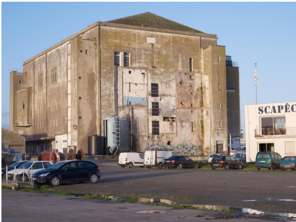
Frigorifique de Lorient : façade Est
