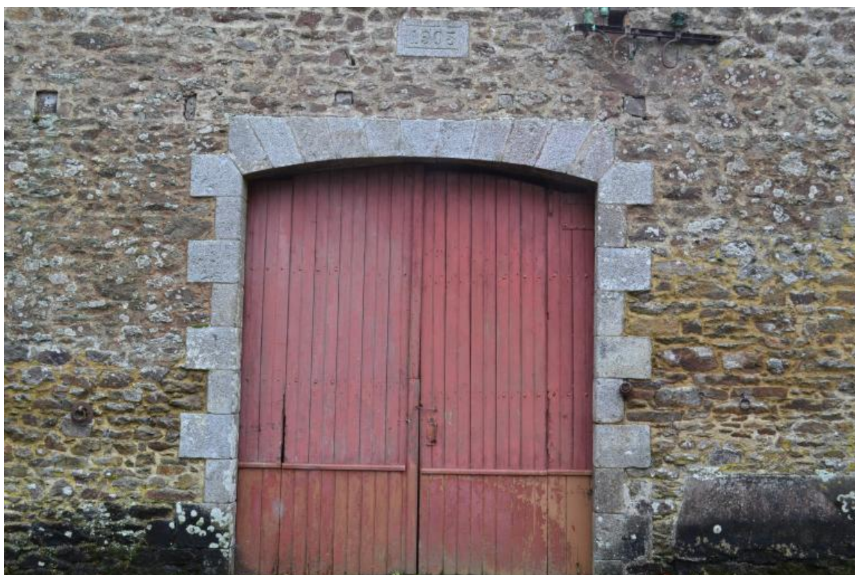
Remise et écuries, 1905. Porte charretière
