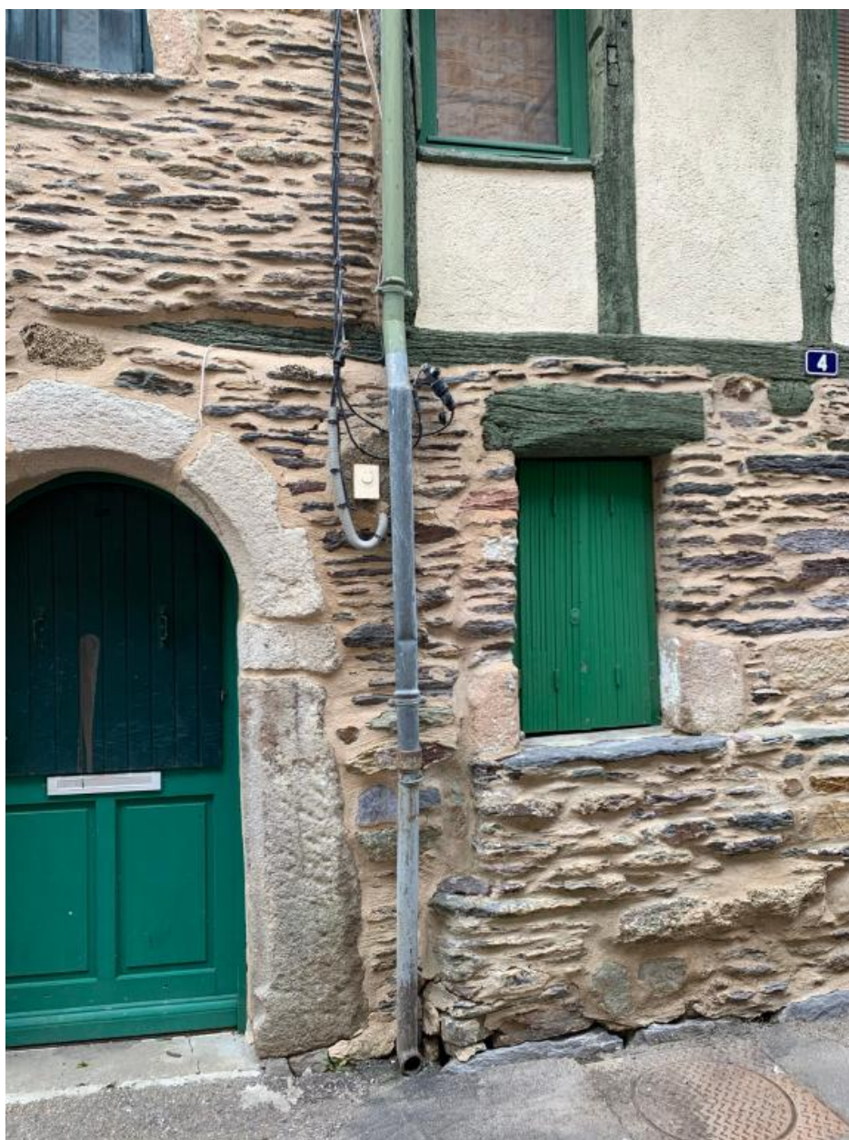
Elévation est, porte et fenêtre
