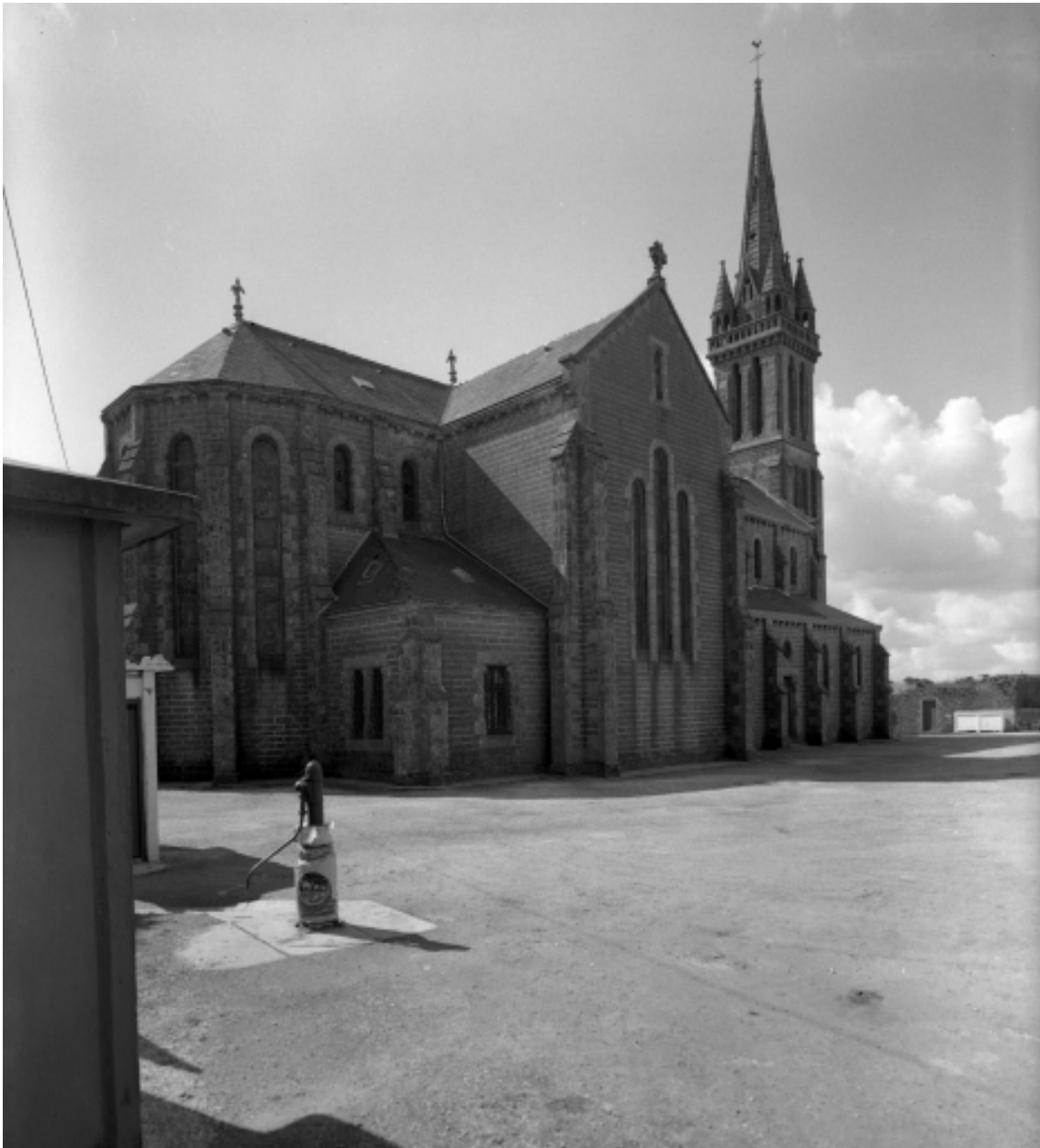
Saint-Ségal, église paroissiale Saint-Séverin : vue générale nord-est, état en 1972
