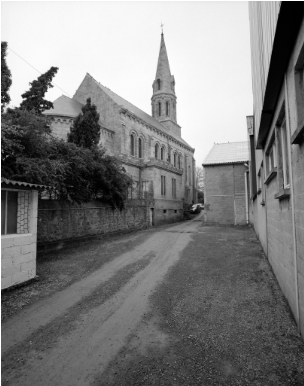
Elévation Nord-Est : vue générale
