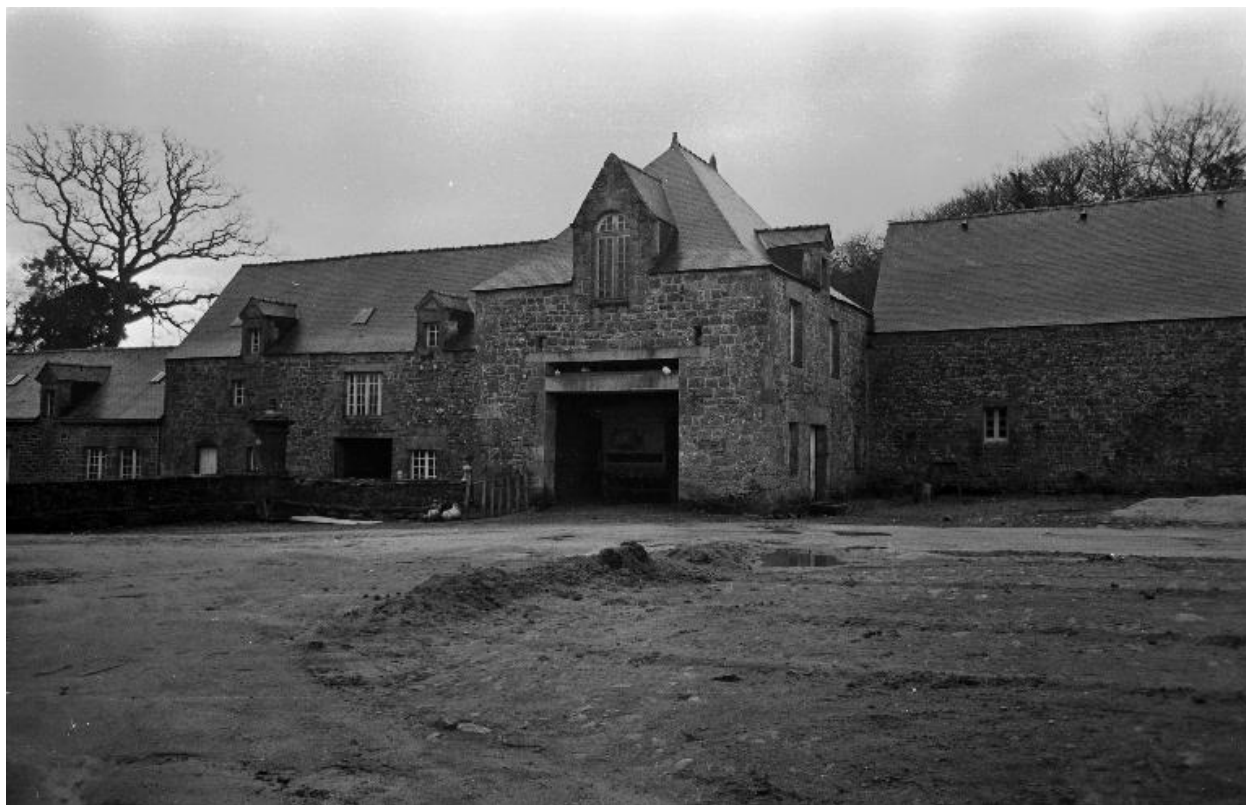
Communs : parties sud-ouest, état en 1969
