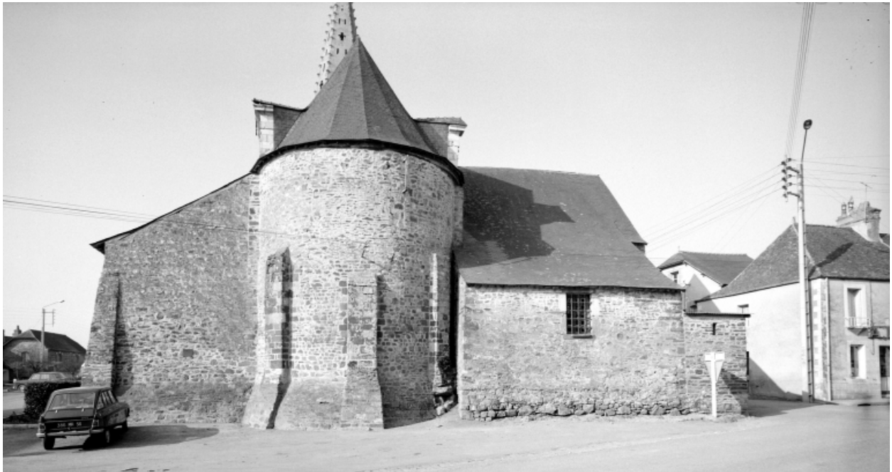
Elévation Est : vue générale
