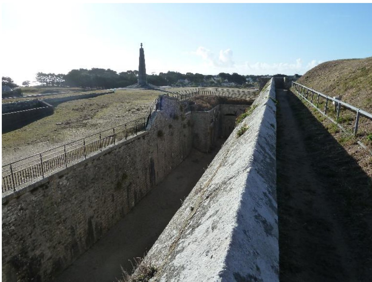
Saint-Pierre-Quiberon, fort de Penthievre, enceinte, mur à bahut de la face est du redan.
