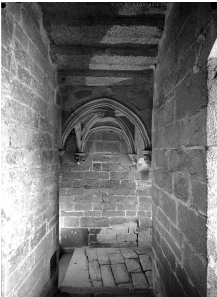
Escalier, 2ème repos du rez-de-chaussée : vue axiale est ouest
