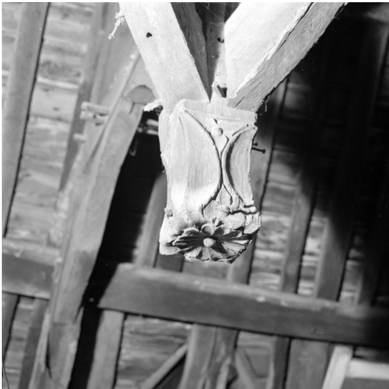
Charpente, extrémité sculptée du poinçon.
