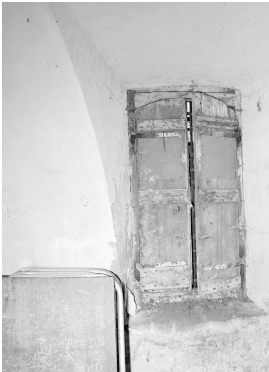
Cachot du rez-de-chaussée sud, vue intérieure volets fermés.
