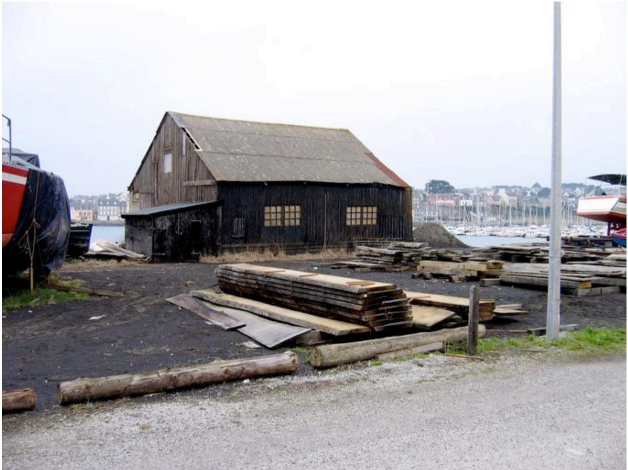
Vue générale de la cabane de sablage
