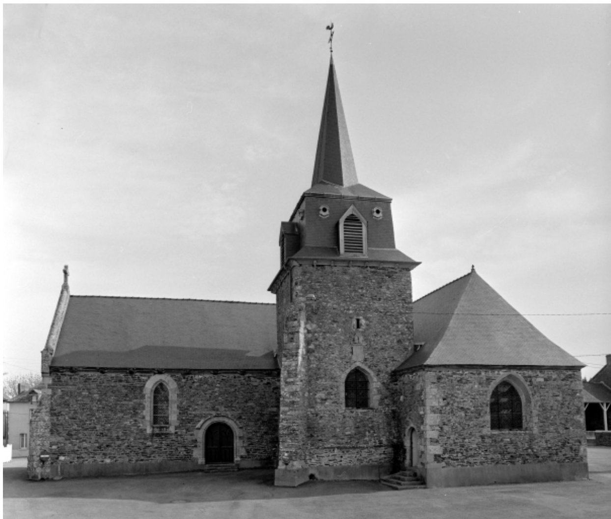
Elévation Sud : vue générale
