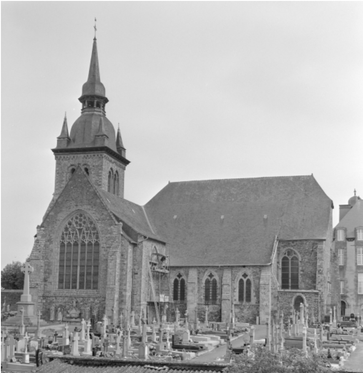
Elévation Sud : vue générale
