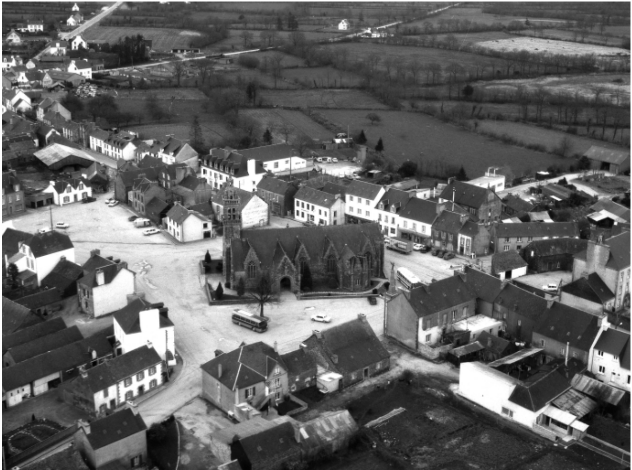
Plonévez-du-Faou, église paroissiale Saint-Pierre : vue de l'église, prise du nord, état en 1973
