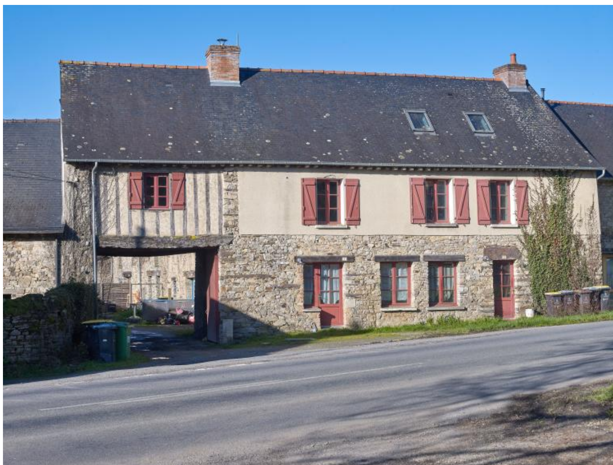
Façade principale du relais de Roudin
