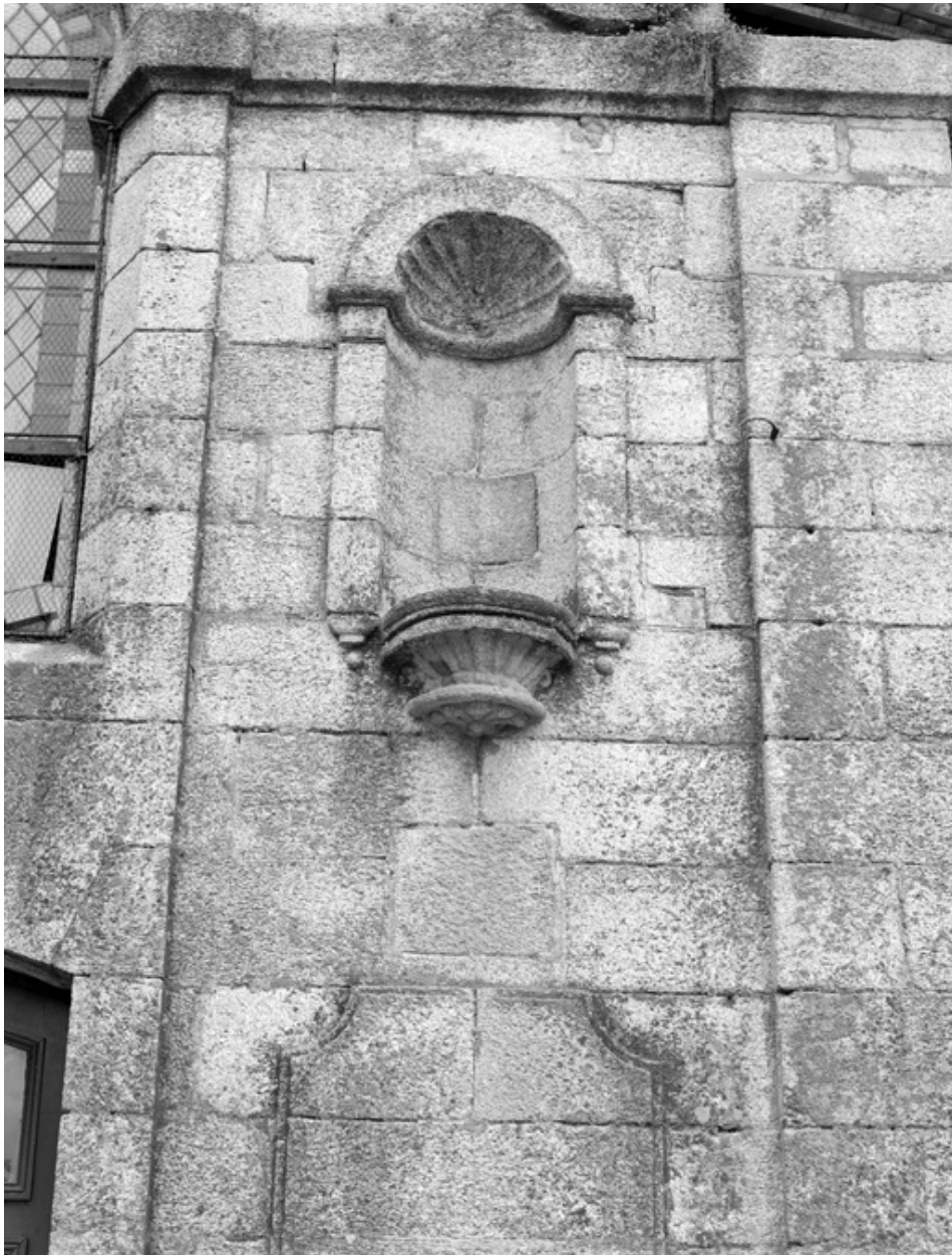
Vue de détail d'un cul-de-lampe d'une niche latérale de la façade principale sud.
