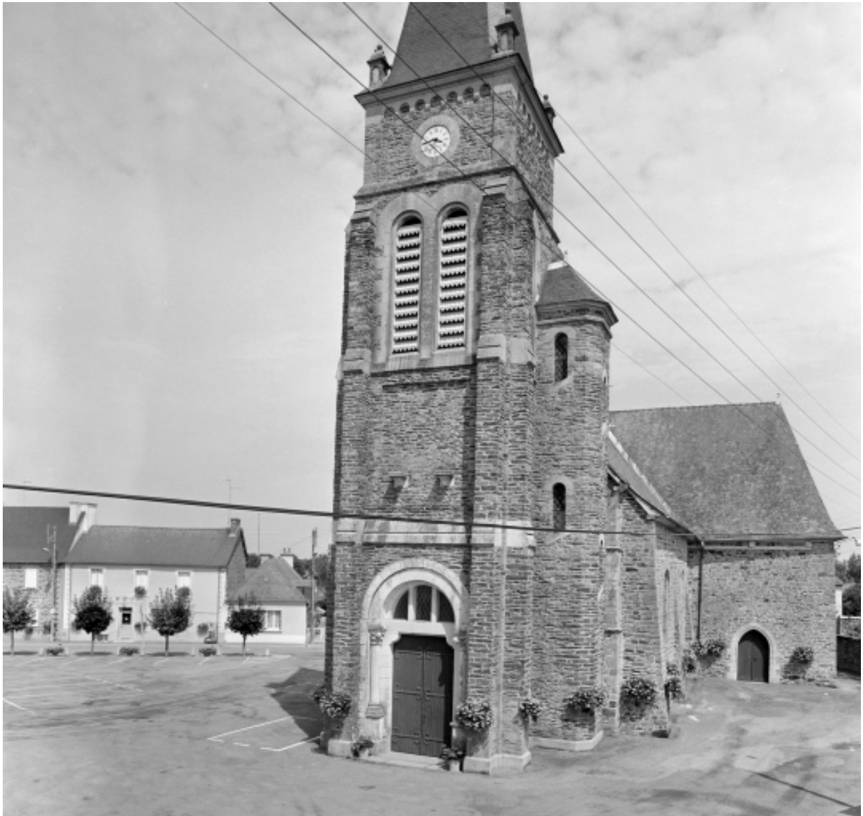
Elévation Sud-Ouest : vue générale
